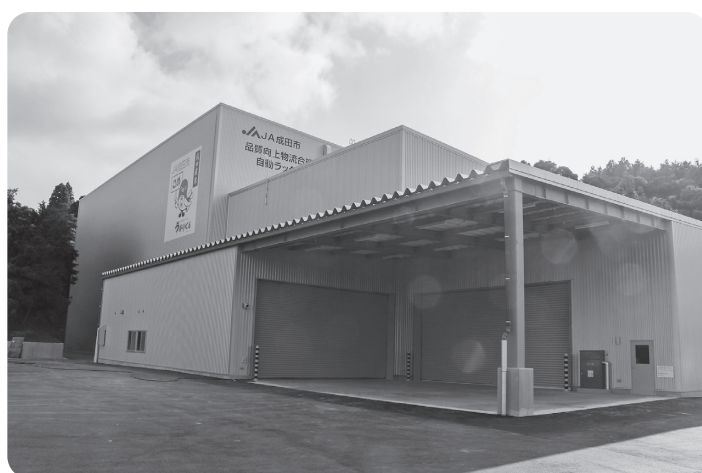
JA成田市品質向上物流合理化施設自動ラック式低温倉庫
